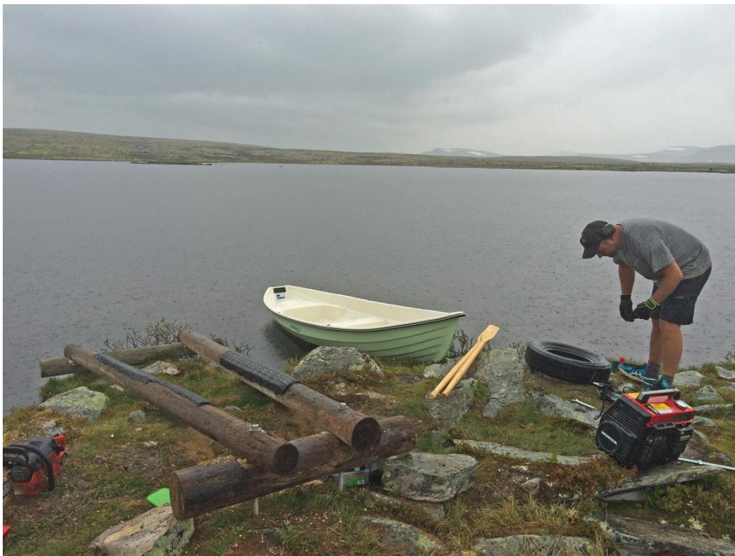
Ny utleiebåt og bygging av båtstøe på Indre Åsdalstjønn
