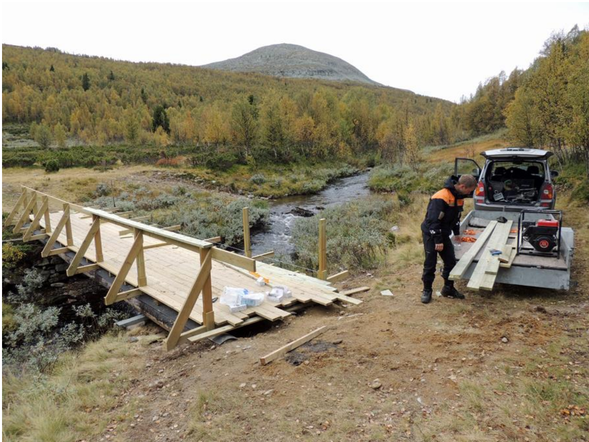
Bygging av ny bro i Åsdalen. Foto: Kristian Hansen
