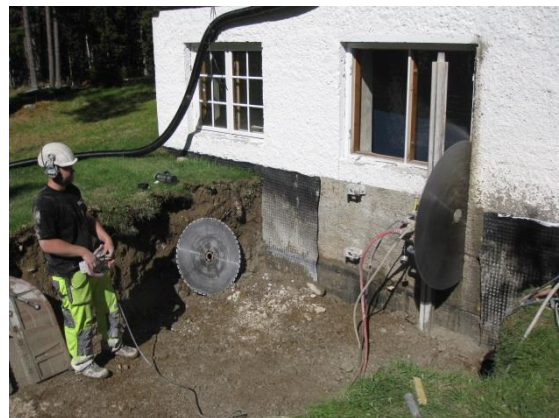
Utsaging av døråpning i internatet. Foto: E. Hagen.
