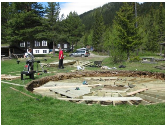
Gulvlegging i storlavvoen. Foto: E. Hagen.
